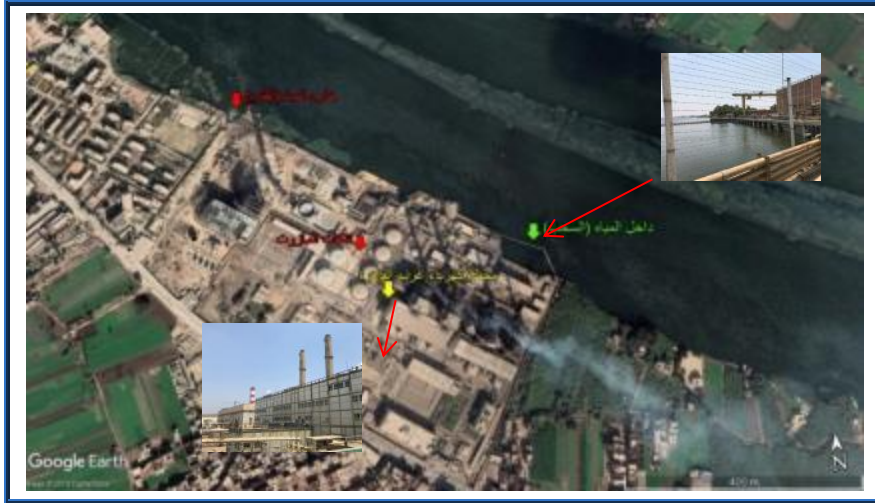
شكل ٦ - محطة كهرباء غرب القاهرة
