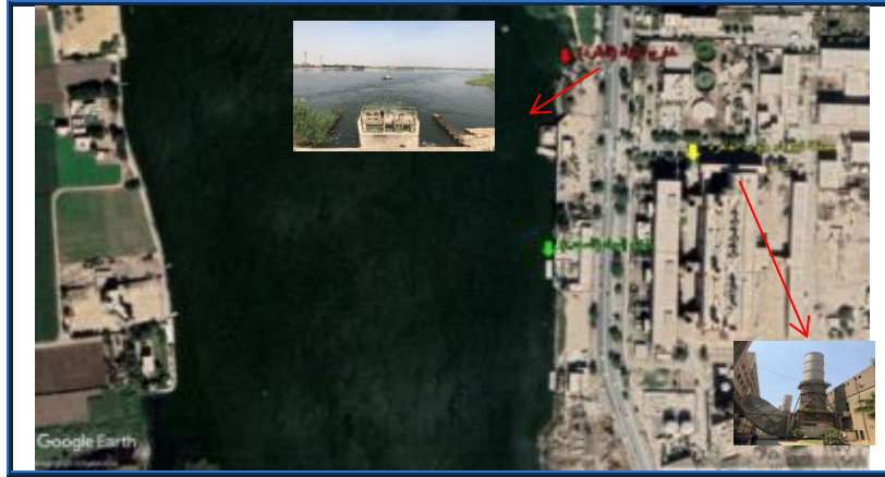
شكل ٢ - محطة كهرباء جنوب القاهرة
